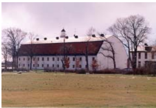
Tunnebodsmagasinet. Foto Olle Melin
